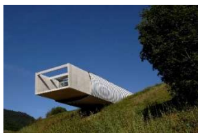
Blick auf den auskragenden Hauptausstellungstrakt Architektur: querkraft © Museum Liaunig
